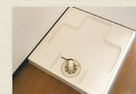
室内洗濯機置場
