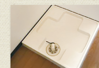
室内洗濯機置場
