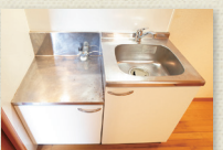
ガスコンロ持込キッチン
