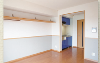
吊棚の居室(1R)
