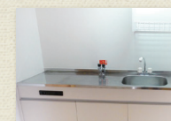
ガスコンロ持込キッチン
