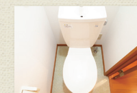
洗浄付便座(取付前)
