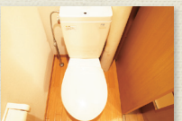
洗浄付便座(取付前)
