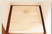
室内洗濯機置場
