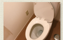
洗浄付便座(取付前)
