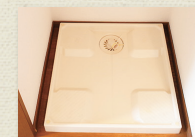
室内洗濯機置場
